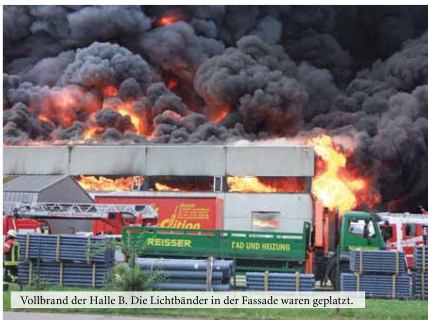
Vollbrand der Halle B. Die Lichtbänder in der Fassade waren geplatzt.
